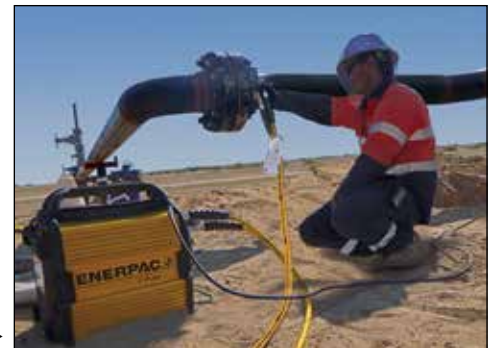
Bomba de torque E-pulse utilizada para aplicaciones de apriete de gran volumen ▶
