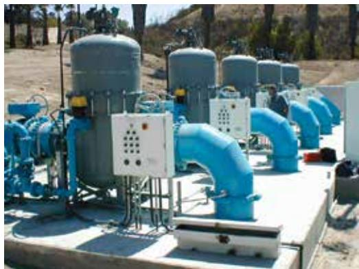
五个24英寸，配备了反冲洗辅助泵的2596型管道过滤器应用于饮用水源水处理中。
