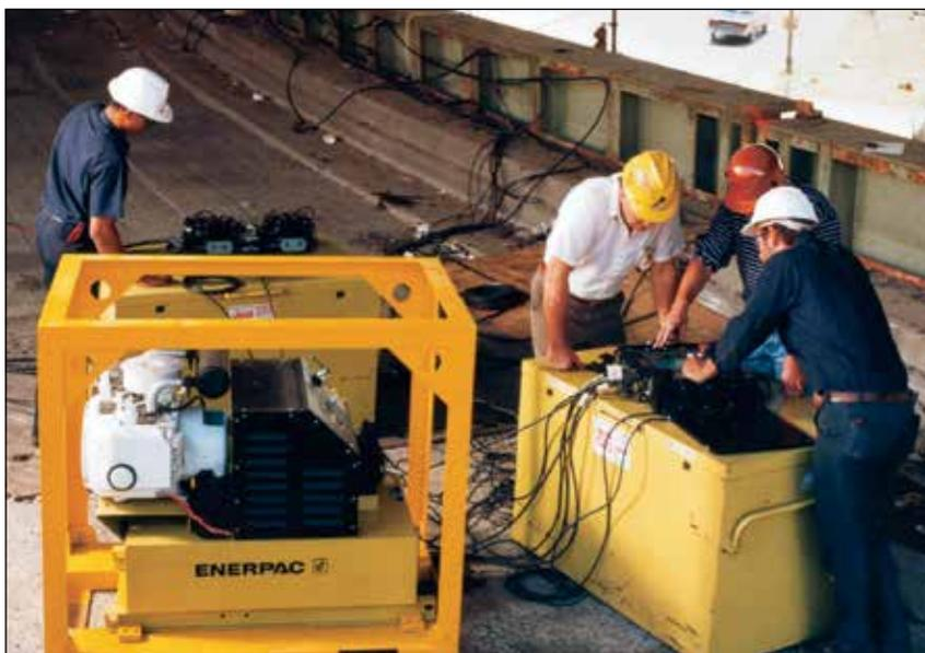
◀ Una bomba de gasolina serie EGM-8000, con especificaciones similares, realiza un levantamiento sincrónico.
